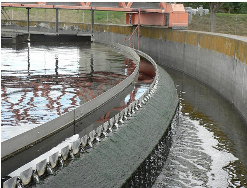
Figura 4.2 - Efluente de um decantador secundário.
