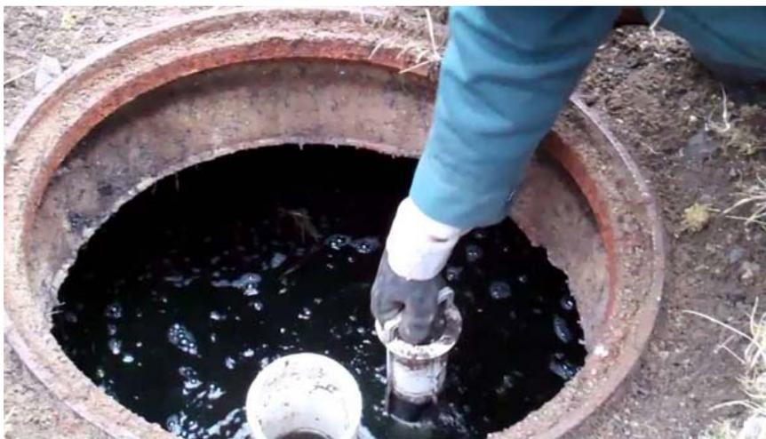
Figura 3.3 – Verificação do nível do efluente no interior de uma fossa séptica.
