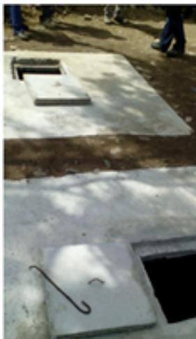
Figura 3.2 - Fossa séptica construída em Cabo Verde, no âmbito do projeto Promosan.
