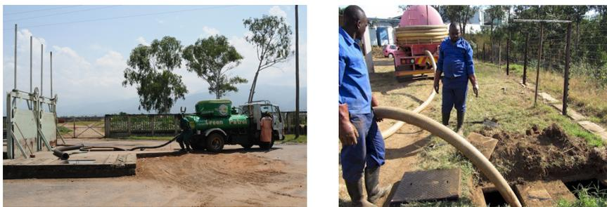
Figura 3.6 - Limpeza periódica de fossas sépticas, com recurso a camião vácuo limpa fossas.
