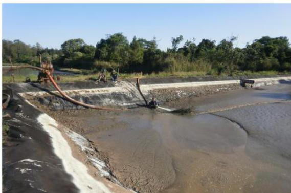
Figura 5.4 – Remoção de lamas de uma lagoa com recurso a camiões limpa fossa.
