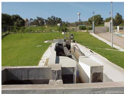
Figura 4.4 - Canal de desarenação/desengorduramento, dispondo a jusante de canal Parshall.
