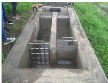
Figura 4.3 - Intervenções de limpeza de uma câmara de grades.
