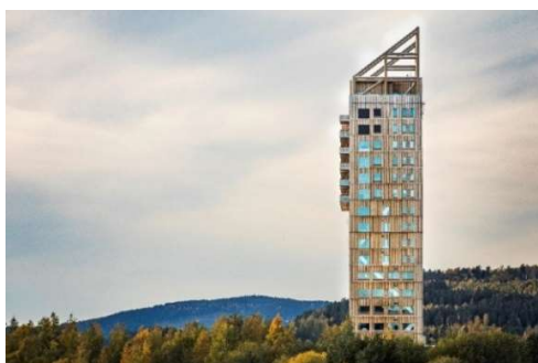
Mjøstårnet- the tallest residential timber building (credit: Ricardo Foto & Voll Arkitekter AS, 2019).
